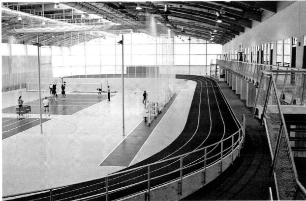
Sporthalle Dresden - polytan PUR Hallenbelag
